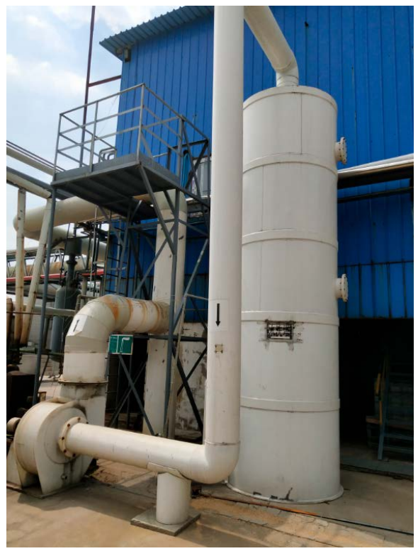
碳纤维废气装置
