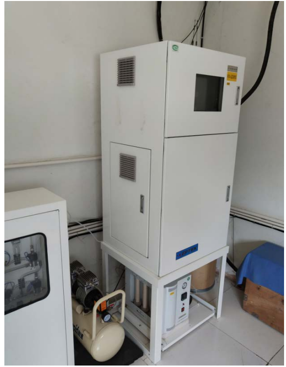
1#废气排放口在线监测设备
