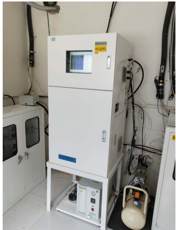
2#废气排放口在线监测设备
